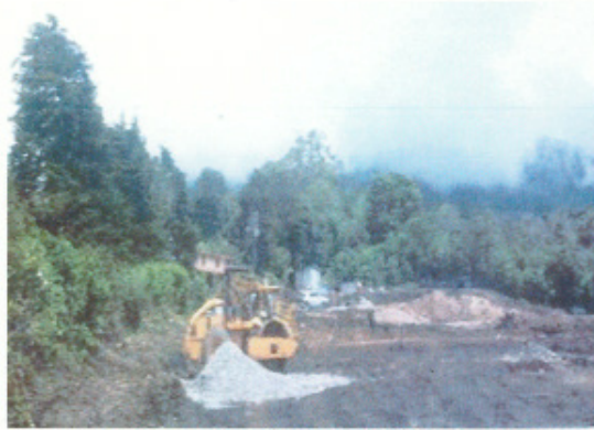
FIGURA 28. Área impactada y maquinarias utilizadas en la ejecución del proyecto.
