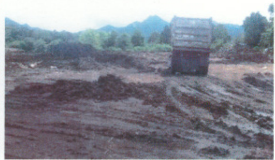
FIGURA 29. Área impactada por el movimiento de suelo.
