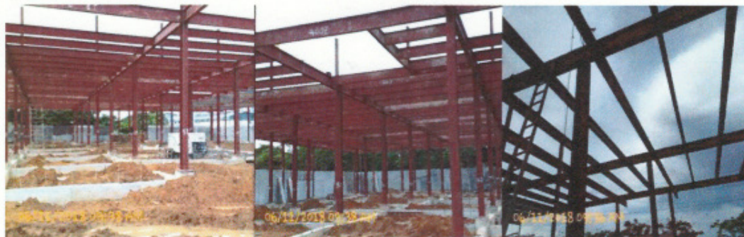
Fotografía No. 1. Vistas del área donde se está desarrollando el proyecto.
