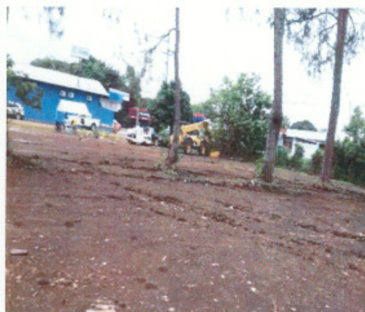
FIGURA 46. Movimiento de la capa vegetal y maquinarias utilizadas
