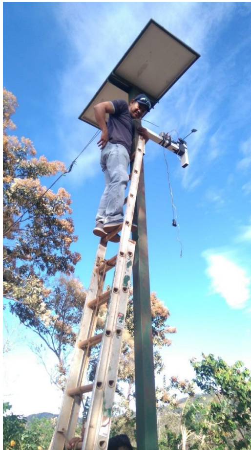
Figura 3. Instalación de los sensores corriente, voltaje, radiación solar y microestación meteorológica.
