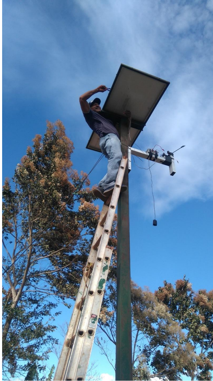
Figura 4. Instalación del sensor para medir la temperatura del panel solar. Fuente: El autor
