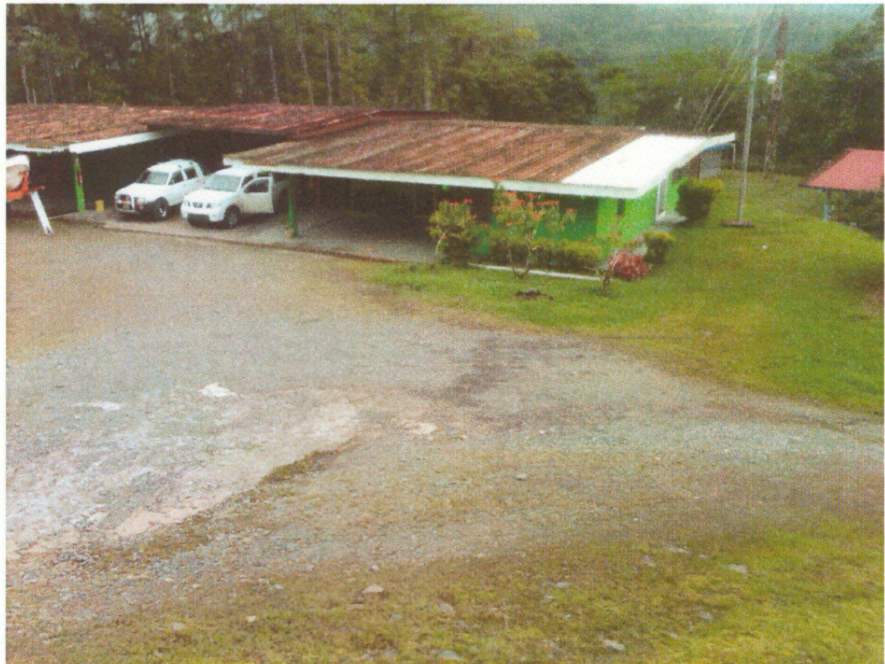
Instalaciones de ENEL Green Power de Fortuna, Chiriquí,
